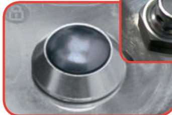
Drücken Sie auf den Innenteil der Sicherheitsventilfeder, um zu prüfen, dass diese nicht verstopft ist.
